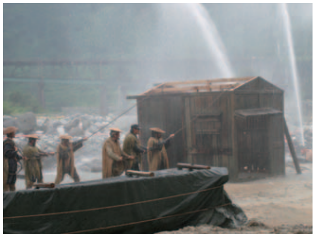
ベースキャンプ解体シーン
